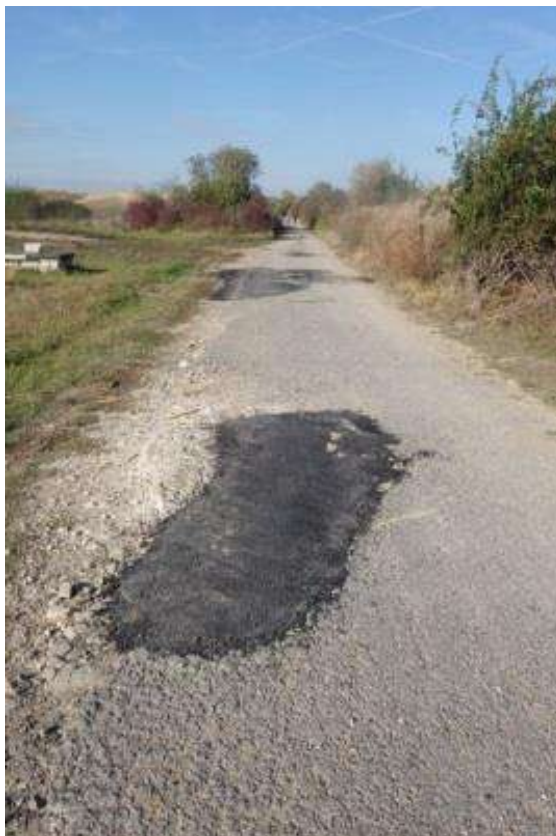
Les nids de poule sur le chemin goudronné ont été comblés. Pourquoi? Par qui? D'après Christian G, ca sent le début des travaux!
