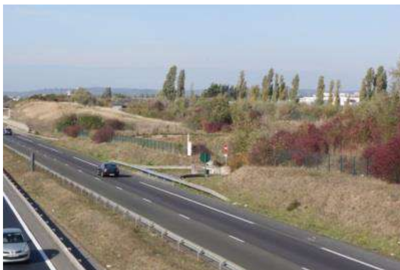
En passant au dessus du BIP, nous remarquons qu'un nouveau rail en métal empêche tout stationnement à côté du potager.
